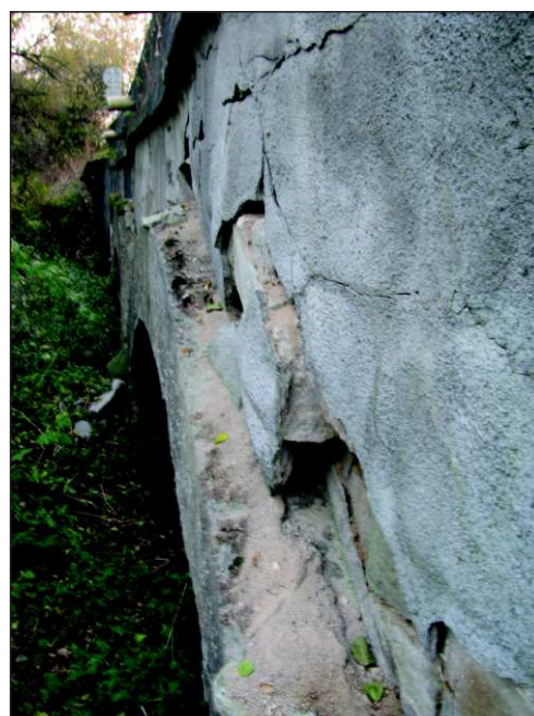
horizontální posun zdiva vně mostu
