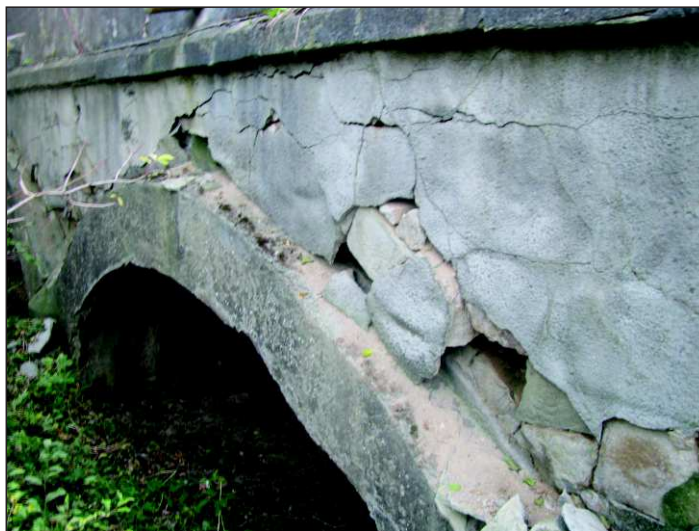
havarijní stav severní strany mostu způsobený provozem těžké dopravy
