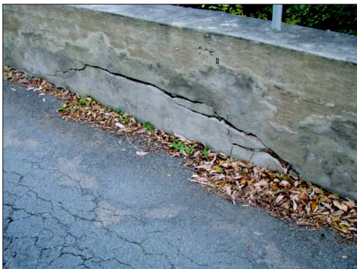
propad vozovky s následnou poruchou zdiva mostu
